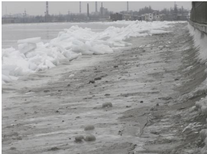
Рис. 6. Наповзання рівних льодових полів на берегозахисну споруду похилого типу з хвилевідбійною стінкою
