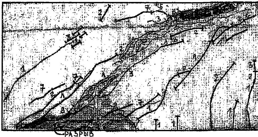
Рис. 4. Характер распределения трещин в железобетонной балке в зоне действия поперечных сил при циклическом и усталостном нагружении
