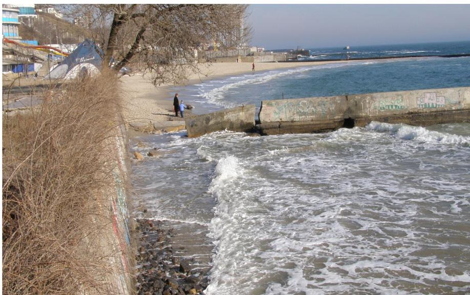
*Рис. 3. Разрушение подмытой буны*
