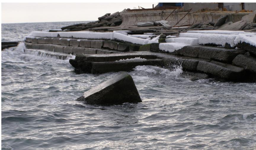
*Рис. 7. Разрушение ступенчатой конструкции*
