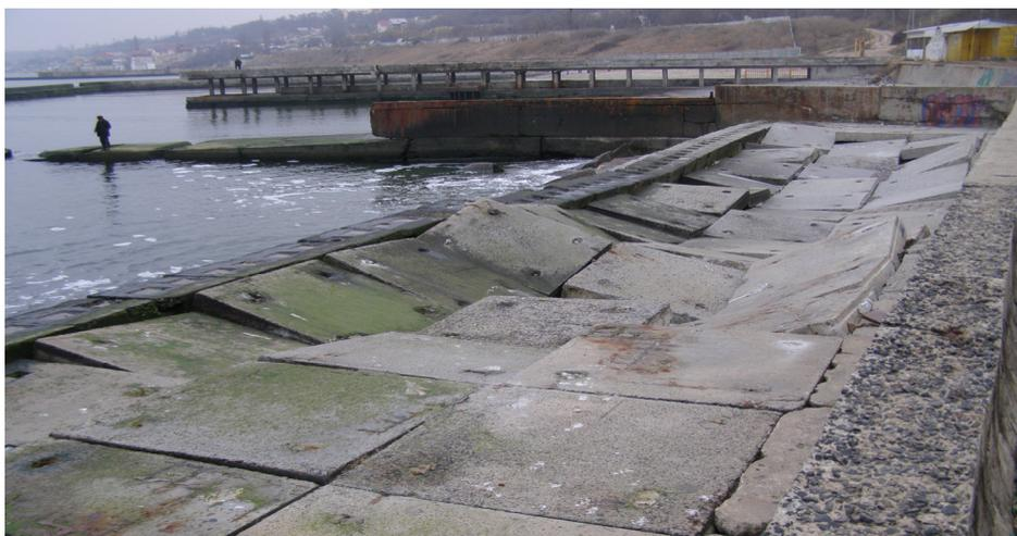
*Рис. 9. Разрушение волнами укрепления откоса, покрытого плитами*
