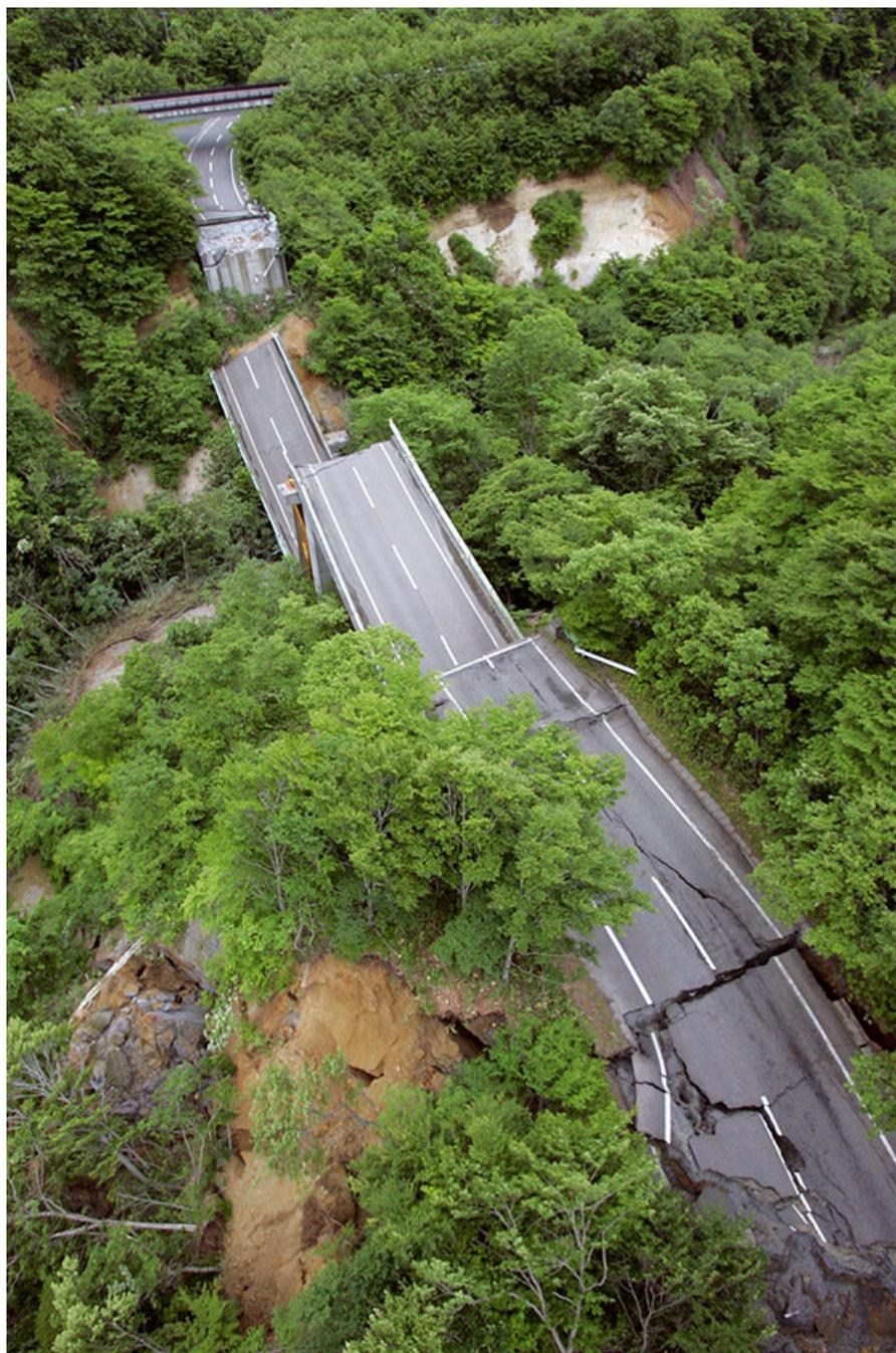
*Рис. 1. Повреждение путепровода, вызванное оползнем*
