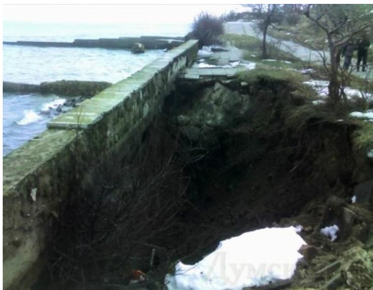
*Рис. 7. Вторая стадия: вымыв грунта за стенкой, затем ее разрушение*
