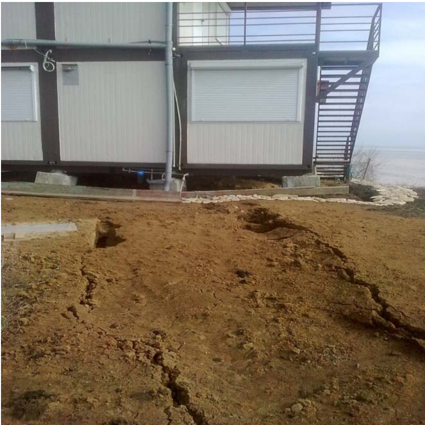
Рис. 11. Идет подготовка террасы к оползню
