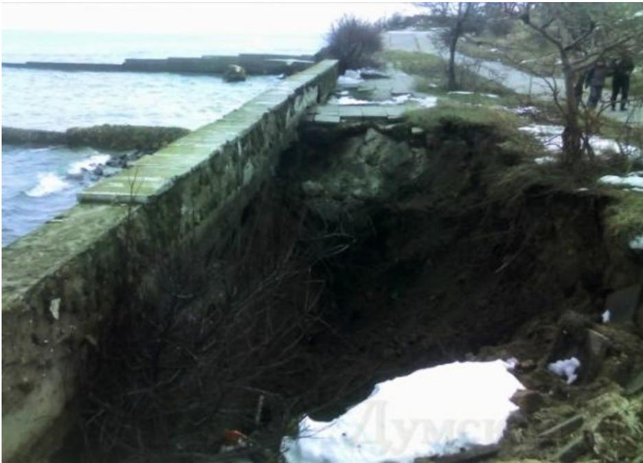
*Рис. 16. Вторая стадия разрушения подпорной стенки*
