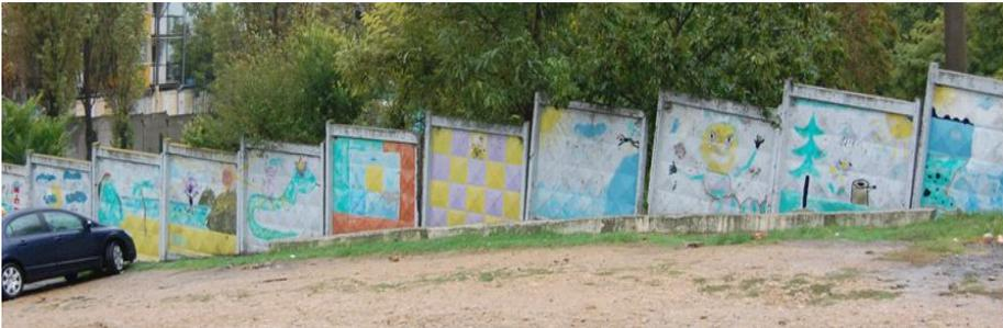
Рис. 3. Деформации секций ограждения
