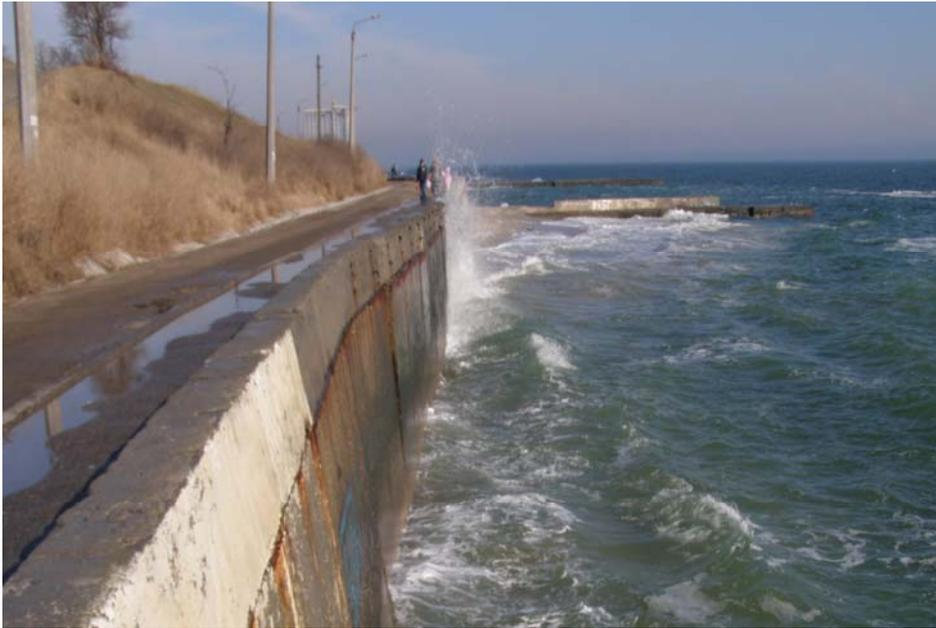
*Рис. 15. Начало разрушения подпорной стенки*
