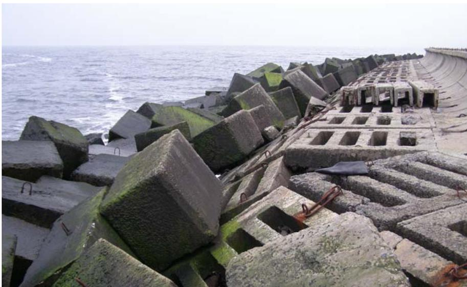
*Рис. 13. Укрепление берега стенкой и массивами*
