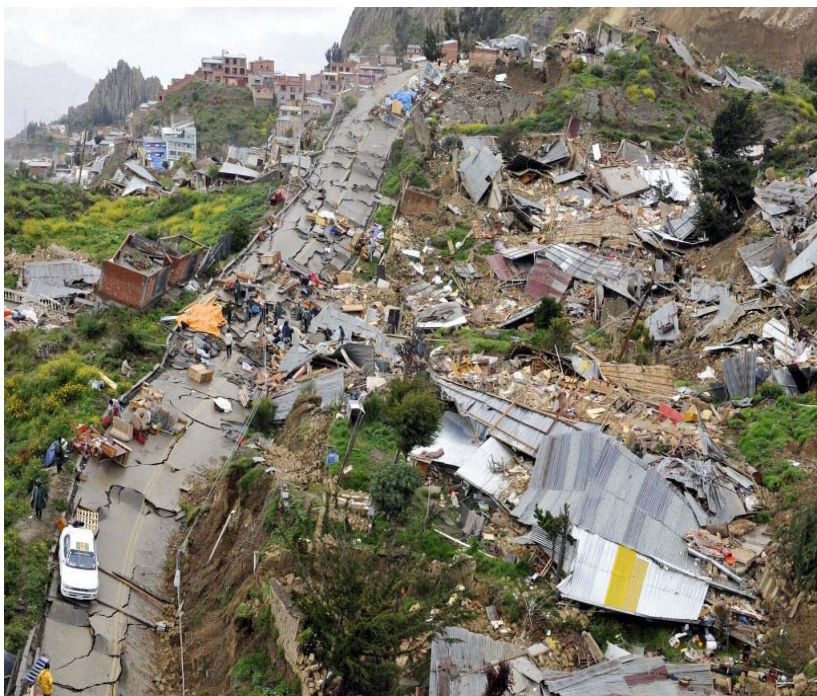
Рис. 2. Оползень в горной местности
