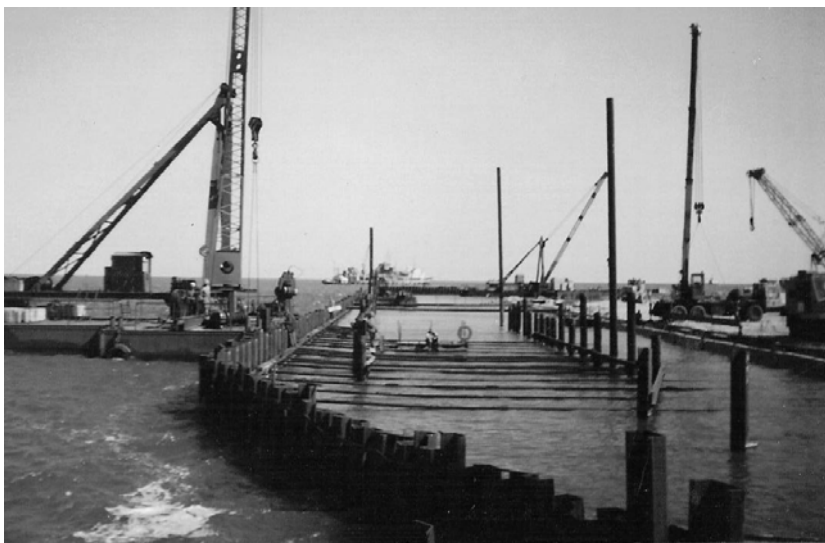
Рис. 1. Строительство перегрузочного комплекса в Мариупольском морском порту. Заанкеренный болюверк из стального шпунта. Устройство лицевой стенки, стальных опор подкрановых путей и стальных анкерных тяг
