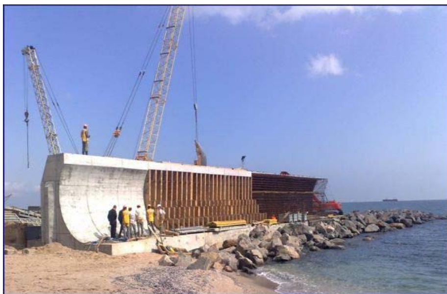
Рис. 3. Сооружение волноотбойной стенки
