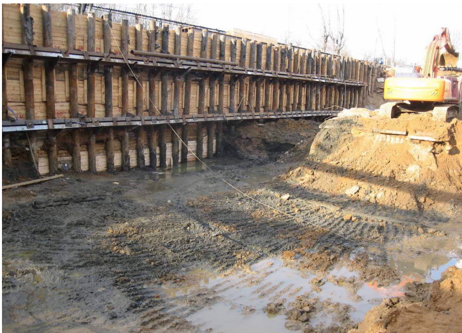
Рис. 4. Котлован с вертикальными укрепленными откосами
