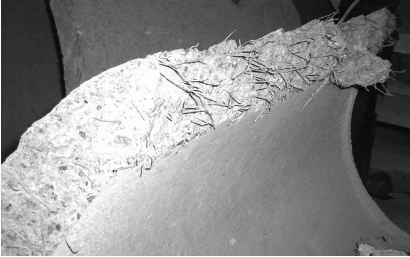
Рис. 2. Равномерное распределение стальной фибры по объему бетона в изломе стенки сталефибробетонной трубы
