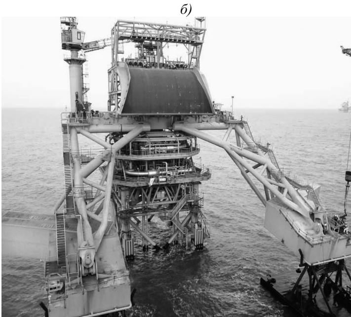
Рис. 7. Стационарный причал типа SYFT (Soft Yoke Fixed Tower): а – конструктивная схема; б – вид на реализованную конструкцию
