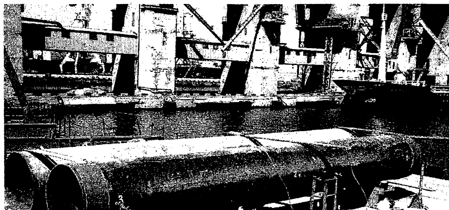
Рис. 1. Натурные исследования несущей способности металлических конструкций: а) сварной шпунт зетового профиля; б) сварные трубы диаметром 1420 мм
