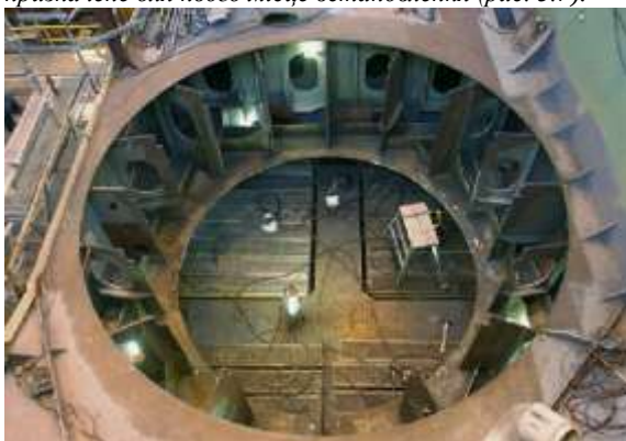
Рис. 3.7. Ділянка корпусу судна, підготовлена для монтажу рульового модуля
