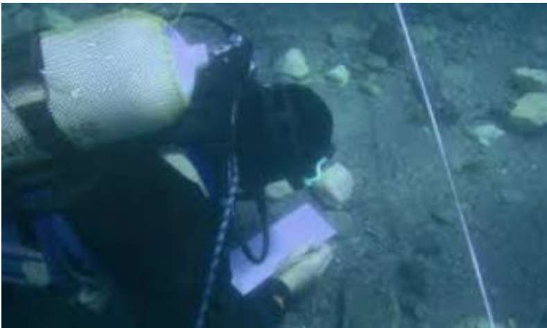
Рис. 6. Підготовка до рівняння постілі водолазом
