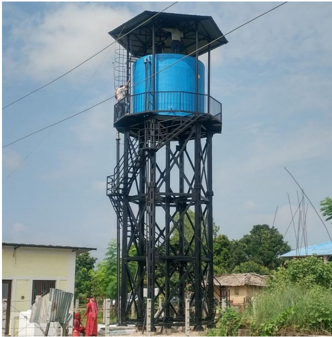
Рис. 6. Водонапірна башта зі скловолокна
