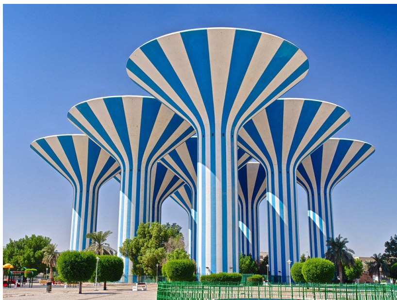
Рис. 5. Приклад веж з воронкоподібним резервуаром
